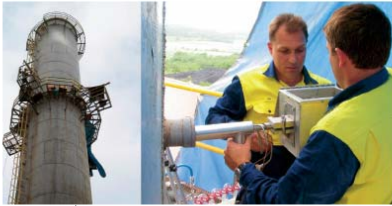
ปล่องปล่อยแก๊สที่มีอุปกรณ์ตรวจวัดมลพิษ และการปรับแต่งตำแหน่งของโพรบเข้าไปในเตาเผา
