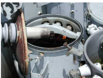
Imagen 2: Aceite de transformadores eléctricos, que contiene bifenilos policlorados
