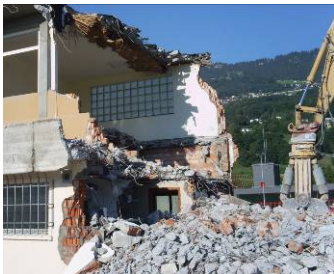
Imagen 5: Residuos de concreto y ladrillos desde una demolición
